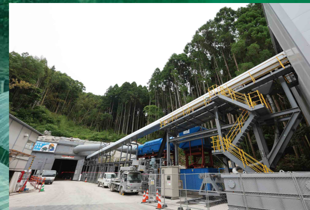
日田5号トンネル ■工法:NATM ■トンネル断面:90m ■トンネル延長:869m
